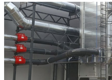
B-FLAP I 隔爆阀的现场安装图
